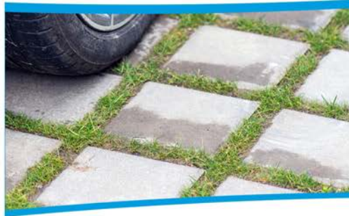
Powierzchnie półprzepuszczalne na osiedlowym parkingu. Fot. Jakub Józefczuk
